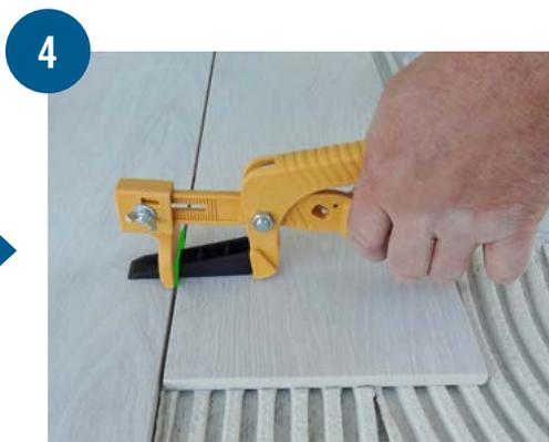
**Posizionare il cuneo con le mani o con l'ausilio della nostra pinza fino a che le due superfici non sono esattamente coplanari**
