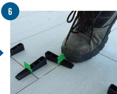
**Alla maturazione della colla provvedere alla rimozione dei cunei operando un colpo deciso sulla testa del tirante**
